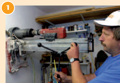
1 Mit einem Spezialgerät wird die Kernbohrung erstellt.
