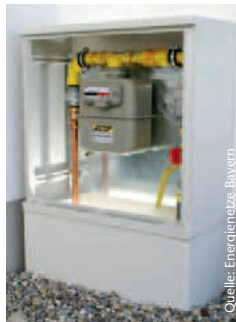
Hausanschlusskasten: geschlossen, offen
