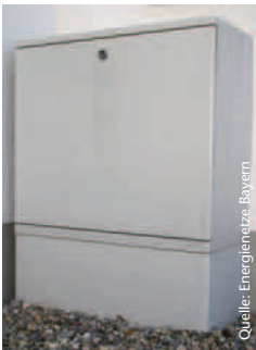
Hausanschlusskasten: geschlossen, offen
