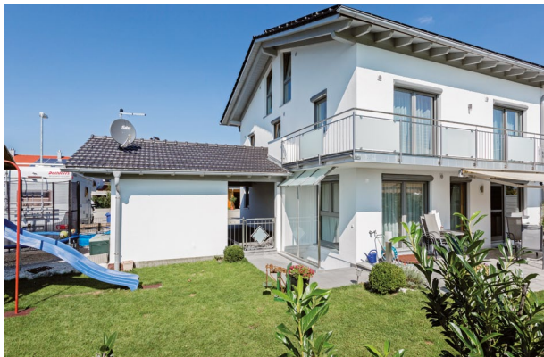
ESB Feldtestanlage Fam. Magnus J. in Freilassing Viessmann Gaswärmepumpe, Wärmequelle (Umwelt) Erdreich
