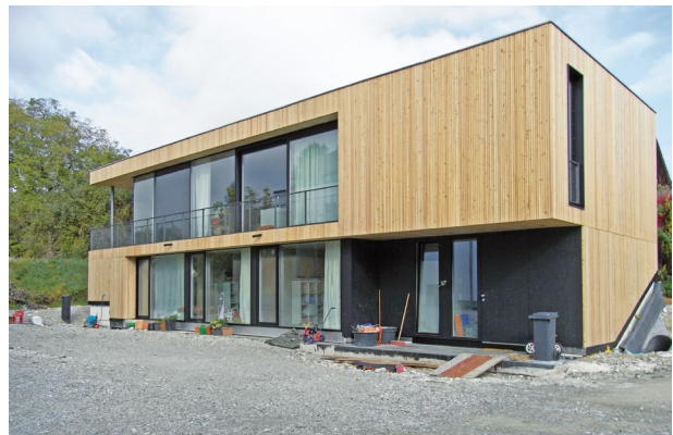
ESB Feldtestanlage Fam. Franz B. in Dießen Viessmann Gaswärmepumpe, Wärmequelle (Umwelt) Erdreich und solare Warmwasserbereitung
