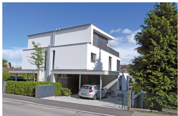
ESB Feldtestanlage Fam. Jan K. in Starnberg Zwei DHH mit je einem Viessmann Gas-Brennwertgerät Vitodens als Referenzanlage (2013 geplanter Umbau einer Anlage auf Vitosorp 200-F (Wärmequelle Solar))
