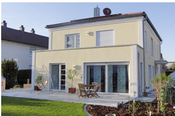
ESB Feldtestanlage Fam. Martin N. in Schrobenhausen Viessmann Gaswärmepumpe, Wärmequelle (Umwelt) Erdreich und solare Warmwasserbereitung
